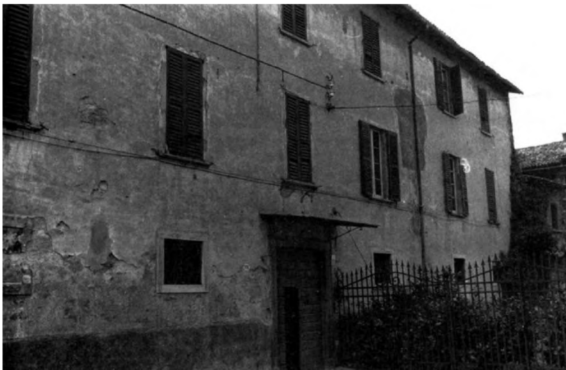
L'antica e rustica casa arcipretale prima della necessaria ristrutturazione.
