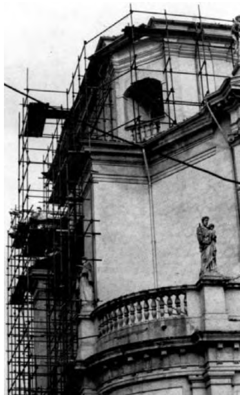
Un aspetto della chiesa parrocchiale durante i restauri
